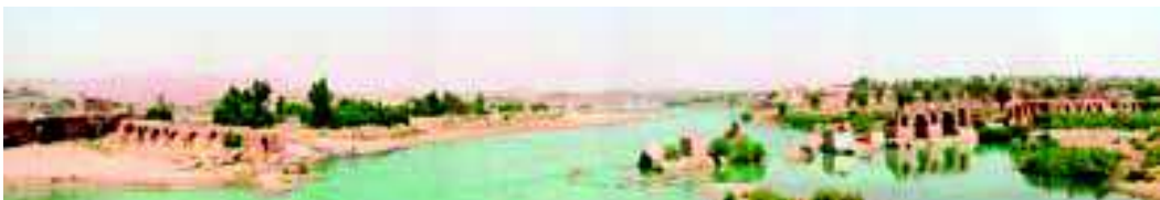
Fig. 6. Veduta panoramica dei resti del Polband-e Shadorwan (Band-e Kaisar) sul fiume Karun a Shushtar, provincia del Khuzestan, Iran; vista da ovest (da ICHHTO 2008: fig. 84).
