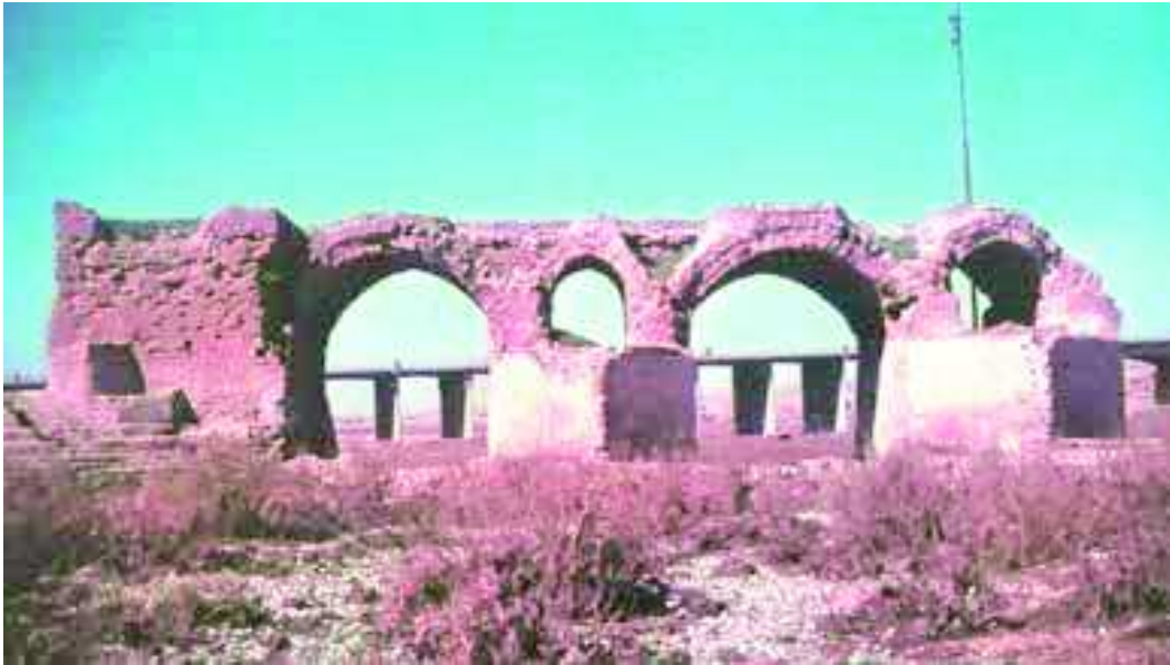
Fig. 9. Dettaglio di alcune pile e relativi rostri a pianta triangolare del Polband-e Shadorwan (Band-e Kaisar) a Shushtar (da Kleiss 2015: fig. 39).
