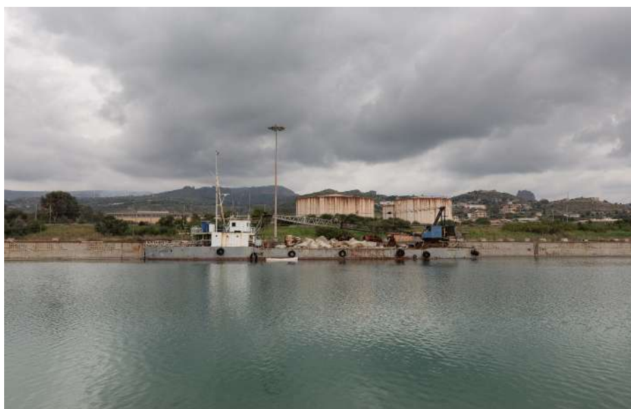
Fig. 32. Silos della Liquichimica con, sullo sfondo, Pentadattilo Fonte: fotografia di Filippo Armonio, 2018
