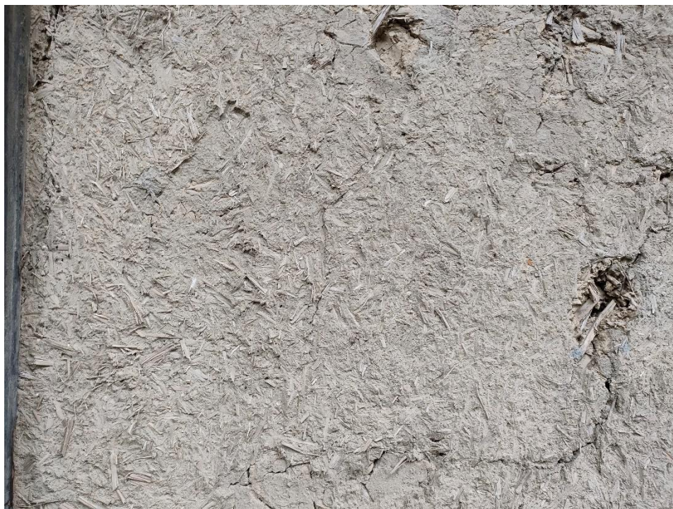
Figura 2.4. Aspetto esterno di una tsuchikabe in ristrutturazione a Nishikyō. I fori visibili sono il prodotto del decadimento dei materiali e dell'azione di insetti e parassiti
