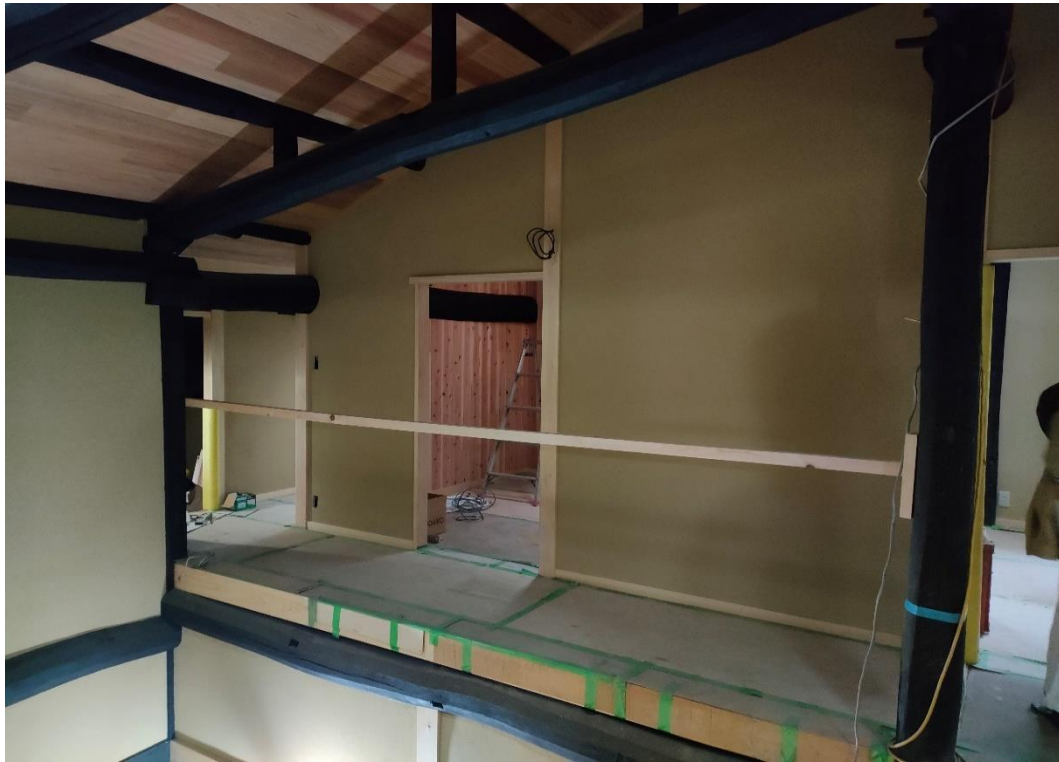
Figura 1.10 Daikokubashira (a destra) e shōkokubashira (a sinistra) di una machiya in fase di ristrutturazione a Nishikyō, Kyōto
