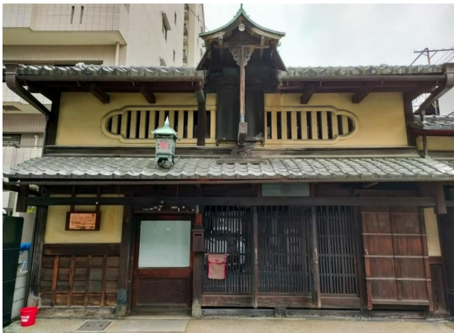
Figura 3.6 Esterni della Hatake jūtaku.
