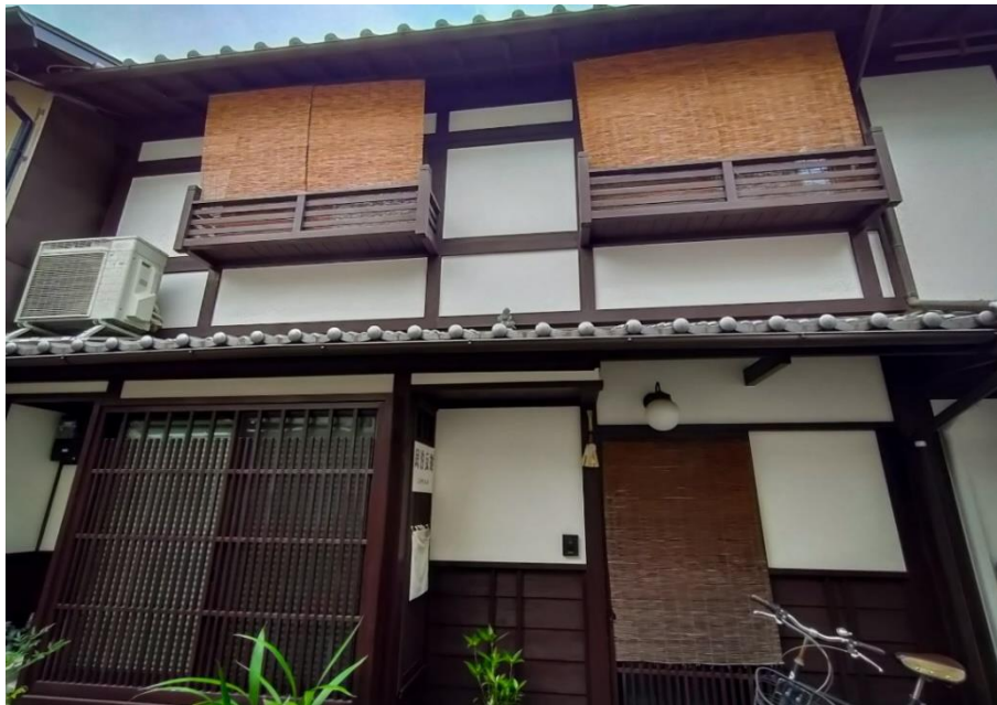
Figura 3.17 Facciata esterna di Ikegamike
