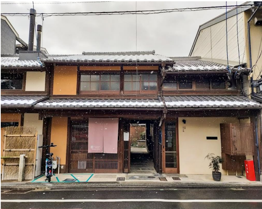
Figura 3.12 Roji a tunnel (Momiji roji) nell’area di Shimogyō. In questo caso, la galleria è formata dai muri perimetrali di locali utilizzati, e il soffitto è in realtà un piano sopraelevato.
