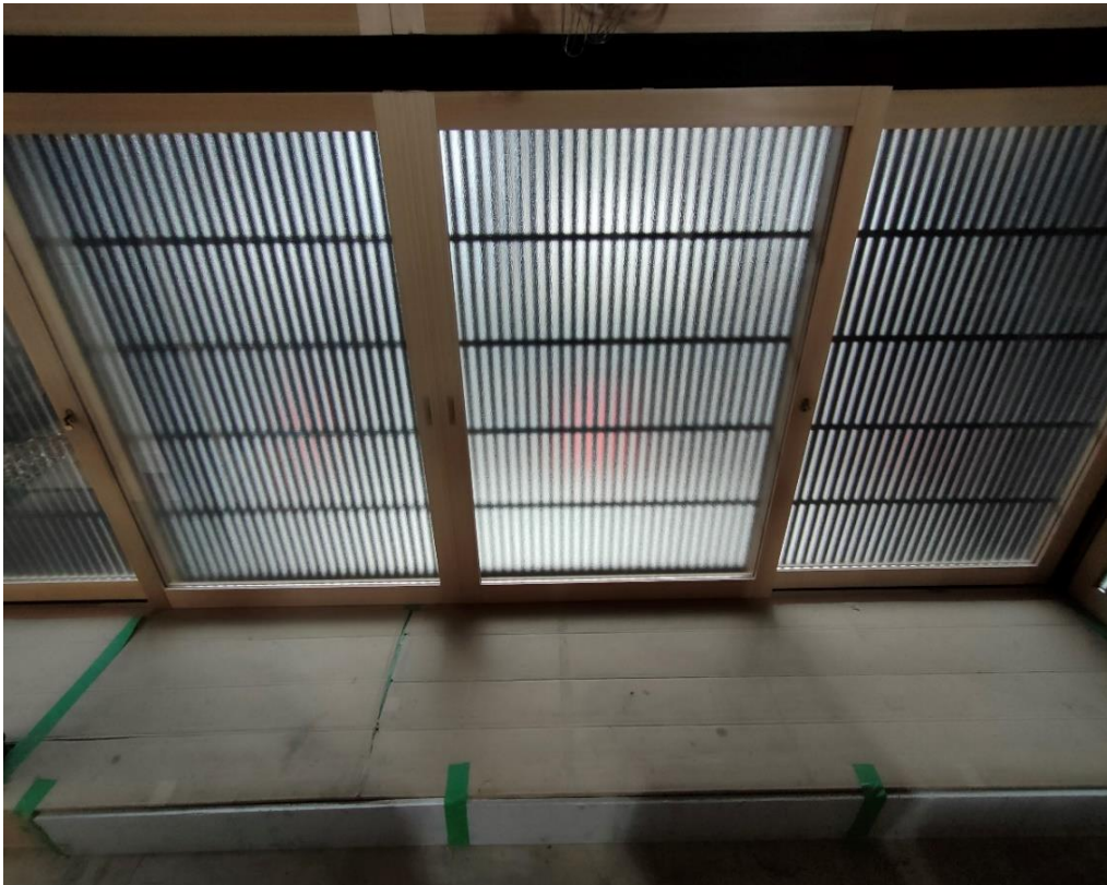
Figura 3.5. Lastra di vetro con intelaiatura in legno applicata al kōshi di una machiya in ristrutturazione.
