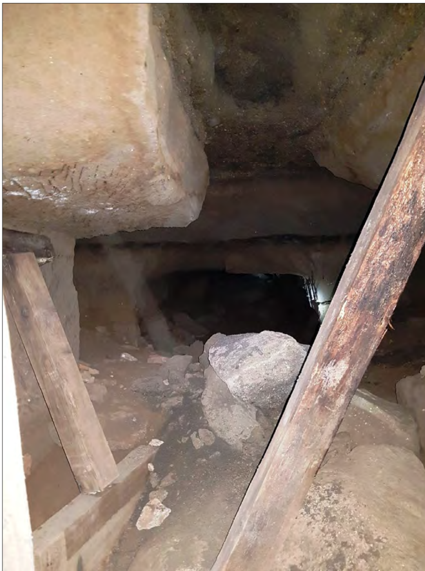
FIG. 7 – Situazione attuale (foto Lacerenza) del tratto intermedio di L con il salto di quota coperto dal cedimento della volta.
