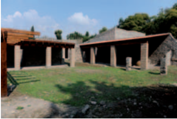
Fig. 61 - Pompéi, tannerie I 5. Les portiques nord et est de la cour après pose des toitures (cliché J.-P. Brun, CNRS-EFR, Centre J. Bérard).
