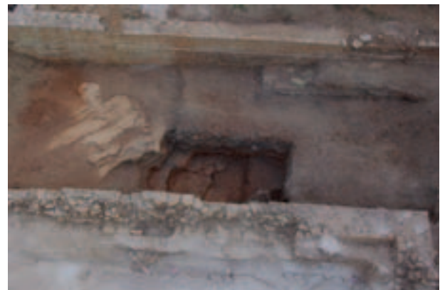
Fig. 11 - Loron. Sondage S31 au nord de la réserve d'eau, avec profil en escalier du substrat (cliché C. Taffetani - EFR).
