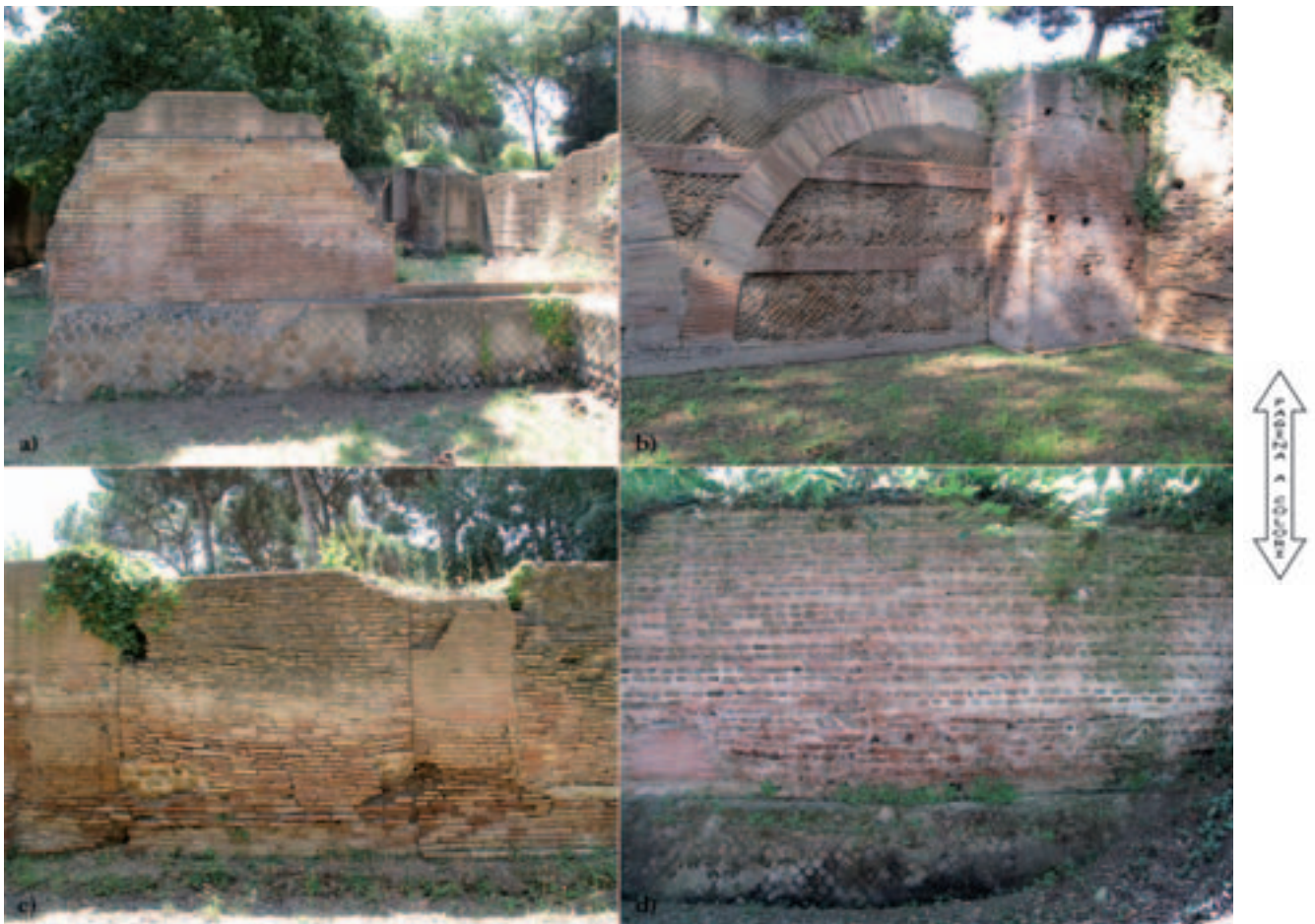
Fig. 87 - Les entrepôts d'Ostie et de Portus. Différentes techniques de parement utilisées dans la construction ou les restaurations successives des magasins de Trajan à Portus (Clichés E.B. et C.S.).
