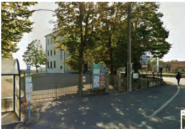
Figura 30.3. La vecchia scuola di Pilastrì prima dell'abbattimento (foto Google Earth Street View, 2011).
