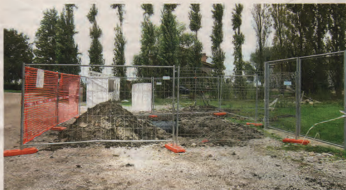
CANTIERE I lavori erano già slittati di due mesi in seguito al ritiro di una ditta che aveva vinto l'appalto
