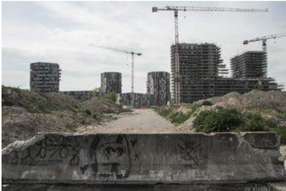
Fig. 8. Il cantiere di piazza Liber Paradisus.
