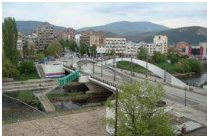
Fig. 6. Il ponte sul fiume Ibar che divide la parte nord (popolata da serbi) e quella sud (popolata da albanesi) di Kosovska Mitrovica. Fonte: pixdaus.com.
