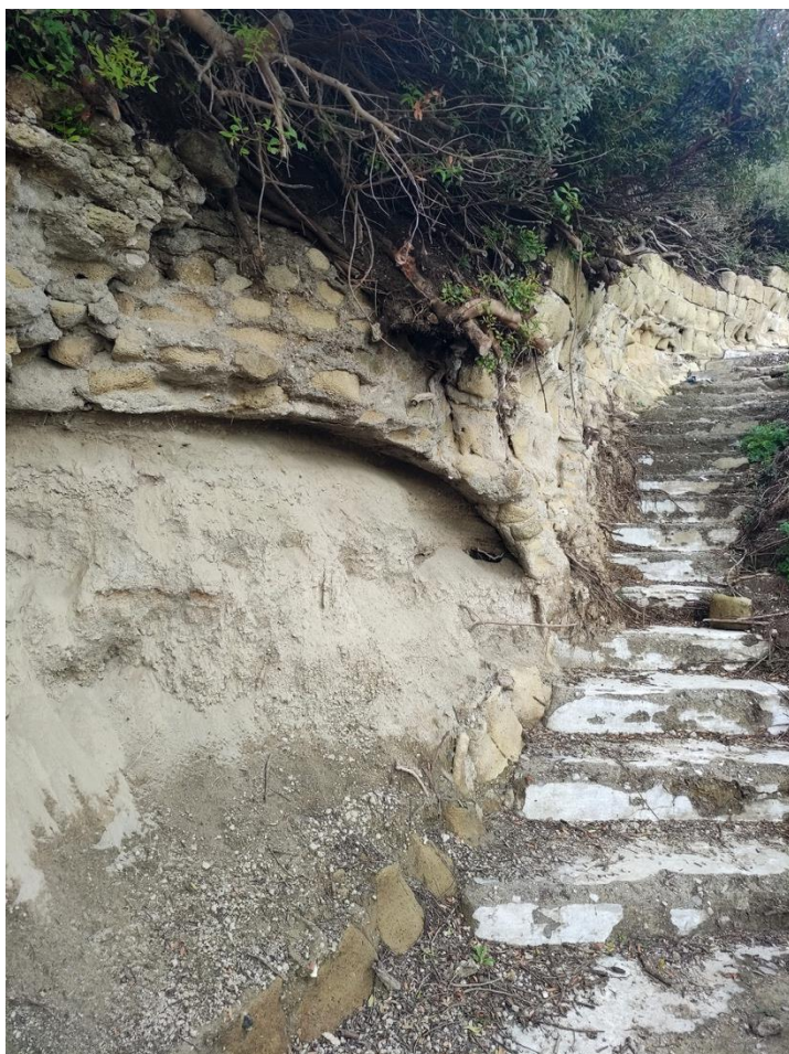
Fig. 14 - Volta in cementizio sovrapposta ai depositi eruttivi, tagliata dalla scalinata di epoca moderna
