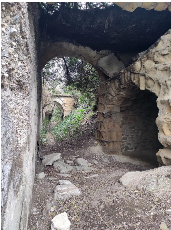
Fig. 15 - Corridoio d'accesso agli ambienti voltati delimitato da un muro in cemento appartenente al periodo bellico
