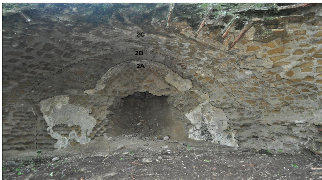
Fig. 6 - Prospetto delle strutture murarie del settore inferiore visto da Est: sono visibili la struttura in reticolato di prima fase (2 A), l'arco di seconda fase (2 B) in opera vittata e la struttura muraria in opera mista di terza fase (2 C)
