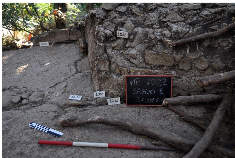
Fig. 4 - Foto di dettaglio della nicchia posta a Nord del saggio. Si tratta di una nicchia quadrangolare in opera reticolata con stipite in opera vittata, e sui paramenti Ovest e Sud è visibile lo strato di rivestimento in cocciopesto
