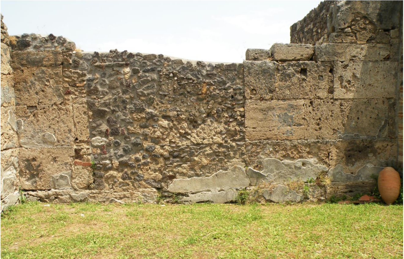
Fig. 10. Il muro est del giardino (8-5), in opera quadrata, con la porta tamponata. Su concessione del Ministero della Cultura – Parco Archeologico di Pompei.
