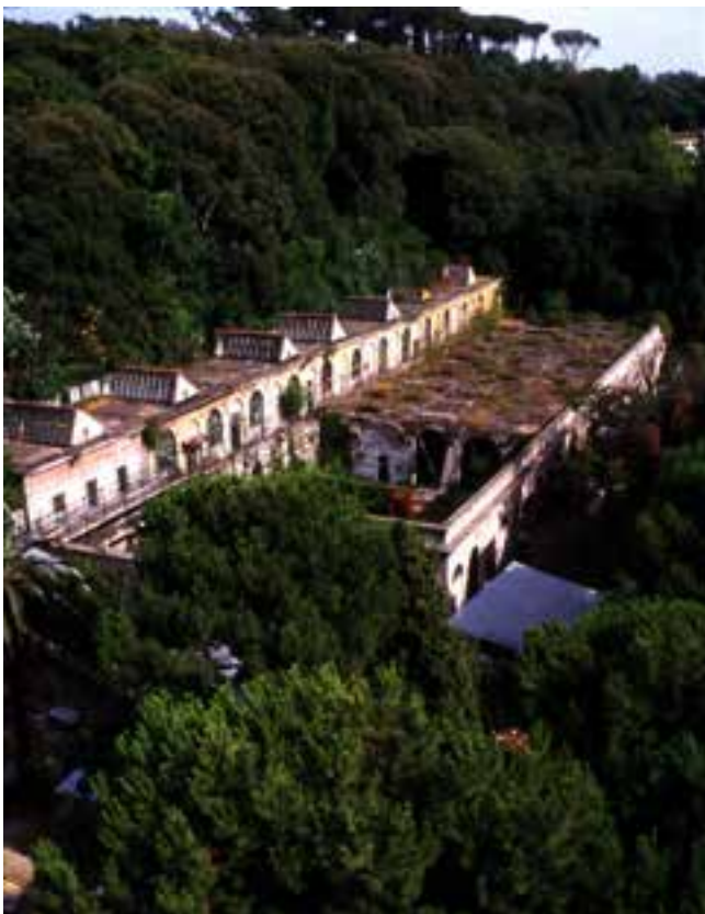
9. Villa Poniatowski. Il fabbricato delle Concerie Riganti (da I. CARUSO, M.A. DE LUCIA BROLLI, "Villa Giulia e Villa Poniatowski. I complessi architettonici e il percorso espositivo: le sezioni topografiche, le collezioni storiche, i settori tematici", in Forma Urbis 4, aprile 2013, fig. 79, p. 37)
