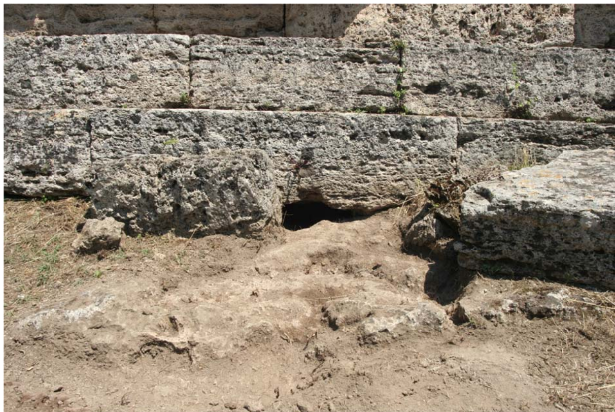
Fig. 17 - Il foro con il segno di cava sotto al blocco inferiore della struttura (A), da Ovest
