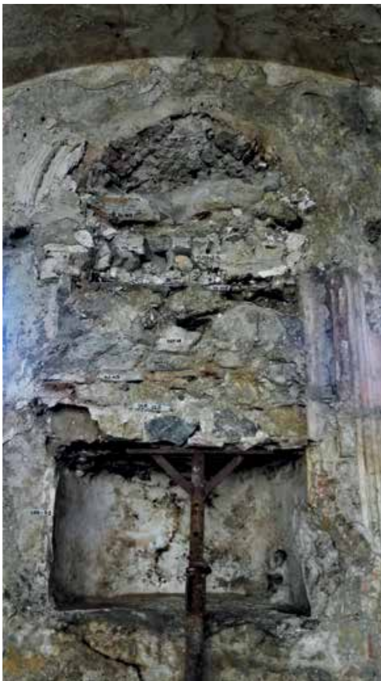
Fig. 5. Chiesa del convento di San Francesco, Policastro Bussentino (Santa Marina, SA). Particolare della nicchia con le sepolture infantili in una delle Cappella laterali (foto Autore)
