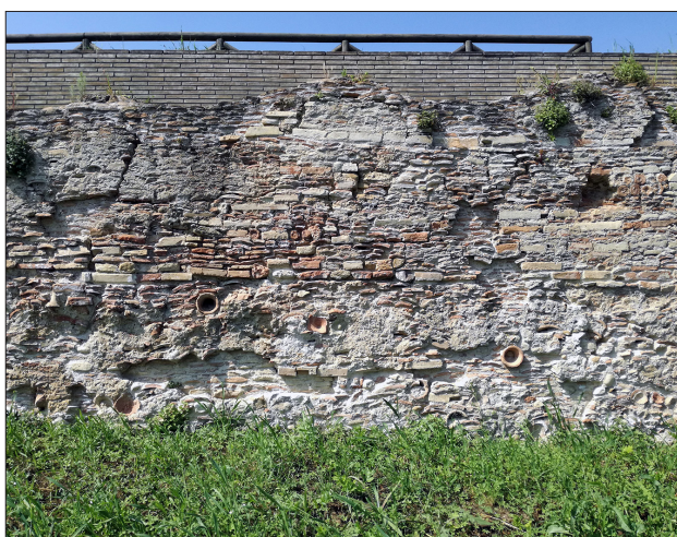
Fig. 11. Tortoreto, villa delle Muracche, sostruzione della terrazza in opus doliare .
