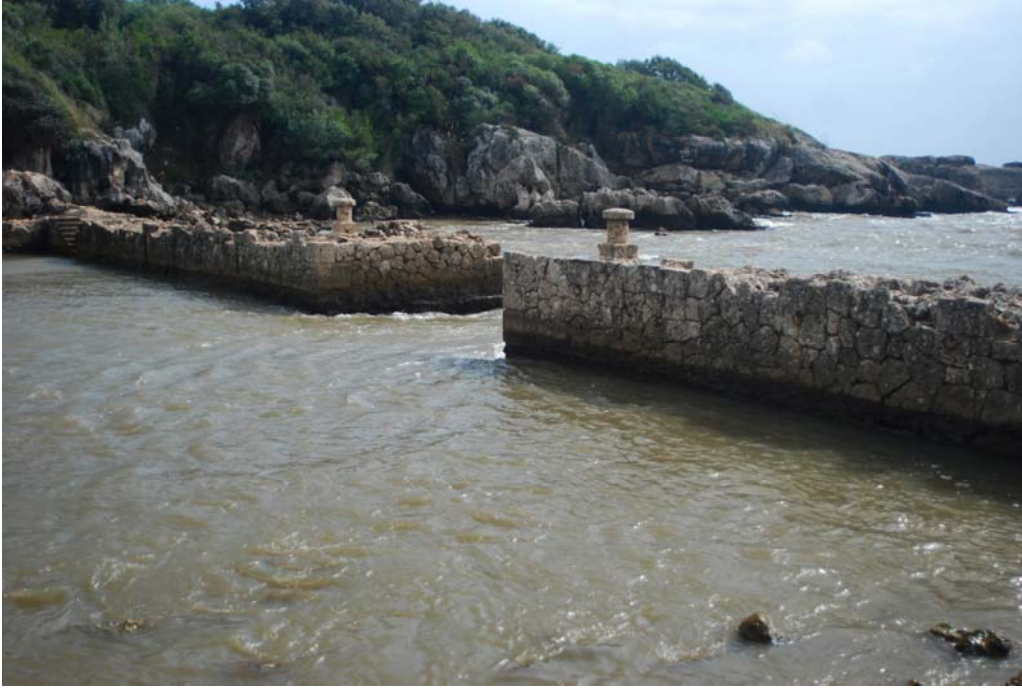
Fig. 5 - I muri moderni al di sopra delle strutture antiche
