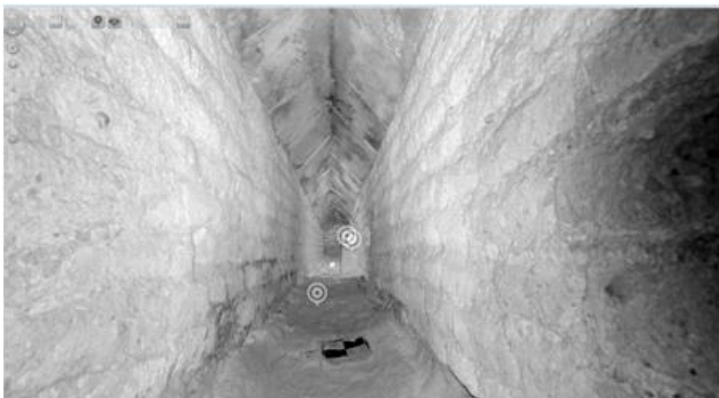
Fig. 5. Rilievo con laser scanner dei condotti di alimentazione del calore (ril. R. Catuogno).
