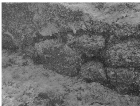
Fig. 12: Particolare di un muro.
