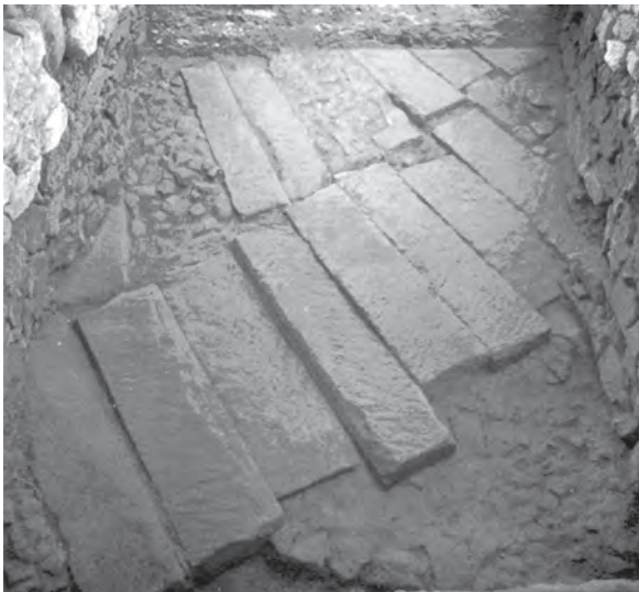
Fig. 3 – La copertura del collettore fognario dell'epoca di Aristodemo, ad ovest della guancia occidentale della porta mediana (cortesia prof. B. d'Agostino).
