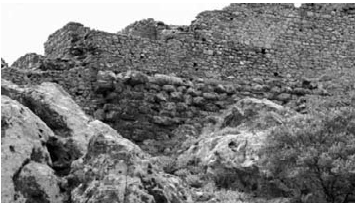
Fig. 86 - Myrina, kastro . Muro di sostruzione dell'acropoli inglobato nel fortino turco (foto autore).
