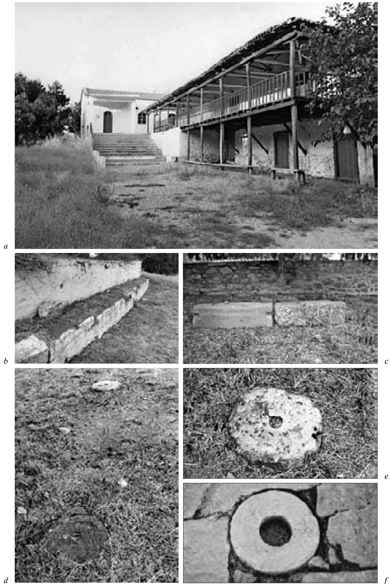
Fig. 137 a-e - Alexopyrgos. a. Monastero della Metamorphossi Sotiros ; b. le fondazioni in blocchi dell'edificio; c. blocchi pertinenti all'antico edificio con torre; d-e. le basi in pietra del portico in legno; f. base in pietra del portico della Vari House (Attica); (a-e, foto autore; f, da: Jones-Sackett-Graham 1973, tav. 68a).
