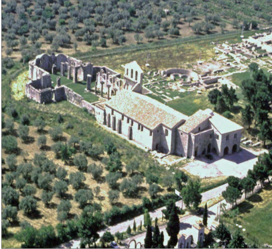
Fig. 1. Foto aerea del complesso della Trinità.
