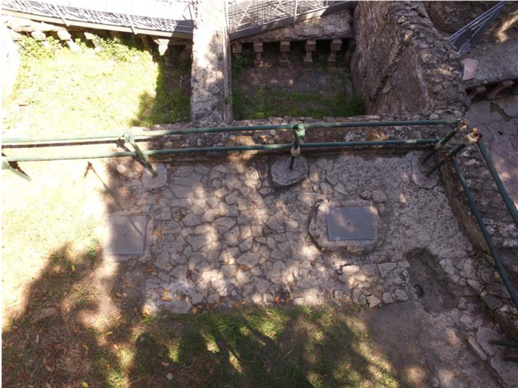
Fig. 7 - Preparazione della pavimentazione del corridoio che corre intorno al complesso termale
