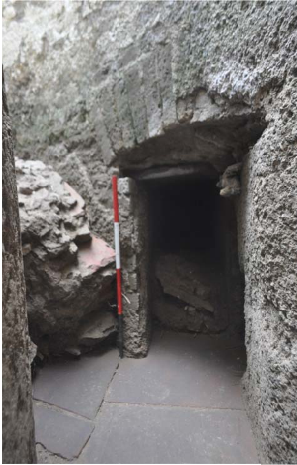
Fig. 9 - Condotto di scolo delle vasche del frigidarium
