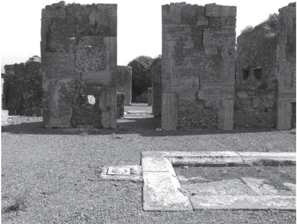
Fig. 53 - Casa del Gallo, particolare delle murature dell'atrio a blocchi di calcare con specchiature in opera incerta di lava.
