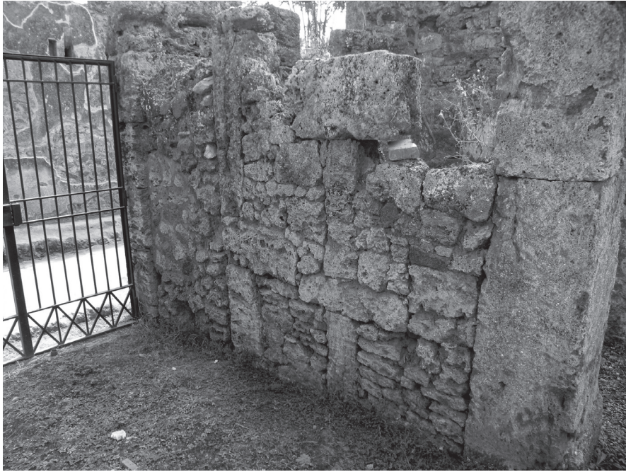
Fig. 77 - Pompeya, Caupona de Amarantus (I 9, 11). Los muros perimetrales y los tabiques se construyeron respectivamente en bloques de piedra caliza y con la técnica del opus africanum .
