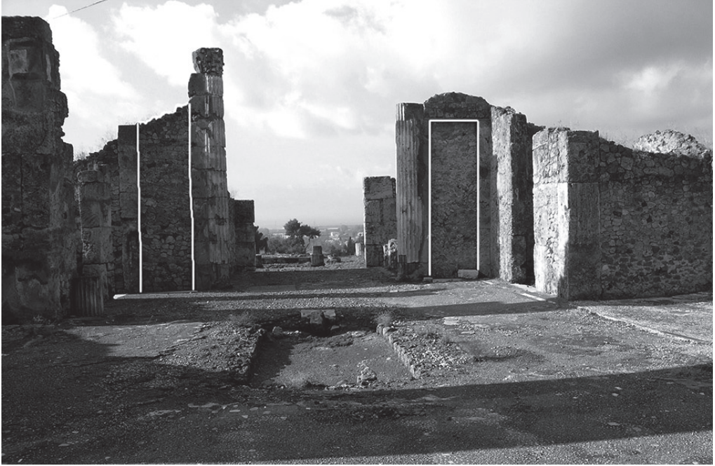
Fig. 47 - Casa di M. Umbricius Scaurus , ingresso nr. 13, atrio tuscanico: tamponature delle originarie porte d'accesso ai triclini.
