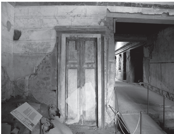
Fig. 33 - Casa di Giulio Polibio, atrio principale: porta dipinta sulla tamponatura dell'originario ingresso al triclinio occidentale.
