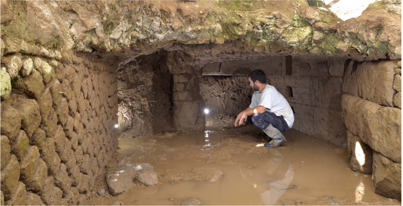
Fig. 6 - Mura settentrionali: il collettore tardo-arcaico, con i relativi rifacimenti di epoca ellenistica e tardo-repubblicana, 2017 (foto: E. Lupoli)
