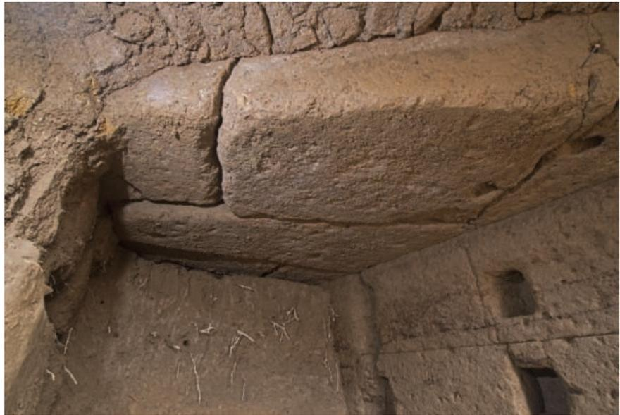
spalletta e al muro di spina, questo sviluppa come superficie di base ca.  $0,6 \text{ m}^2$  (ca.  $1,25 \times \text{ca. } 0,48 \text{ m}$ ); se moltiplichiamo questa misura per la presunta altezza di  $0,75 \text{ m}$ , otteniamo un volume di ca.  $0,45 \text{ m}^3$ , con un peso presunto che oscilla approssimativamente tra  $495$  e  $765 \text{ kg}$ : a quest’ultimo *range* si riferisce, dunque, grosso modo il peso della maggior parte dei blocchi di copertura del condotto.
