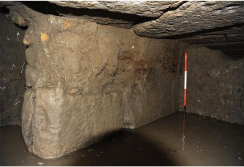
Fig. 31. L'imbocco del collettore tarso-arcaico, da Sud-Est: particolare del muro di spina originario in ortostati col rifacimento nel tratto superiore iniziale in opera cementizia di epoca tarso-repubblicana (foto: M. D'Acunto)
