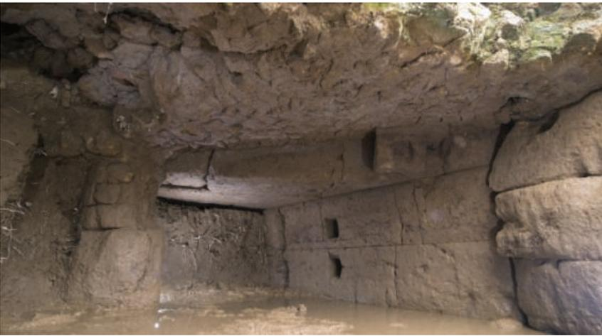
Fig. 32. Il collettore tarso-arcaico – il canale orientale, da Sud: a sinistra, il muro di spina col rifacimento tarso-repubblicano della parte superiore del tratto iniziale, in cui si riconosce il paramento in opera vittata; in alto, la copertura in blocchi di epoca tarso-arcaica, a cui si appoggia la volta tarso-repubblicana; a destra, la spalletta tarso-arcaica, a cui si appoggia l'“adduttore” ellenistico (foto: E. Lupoli)
