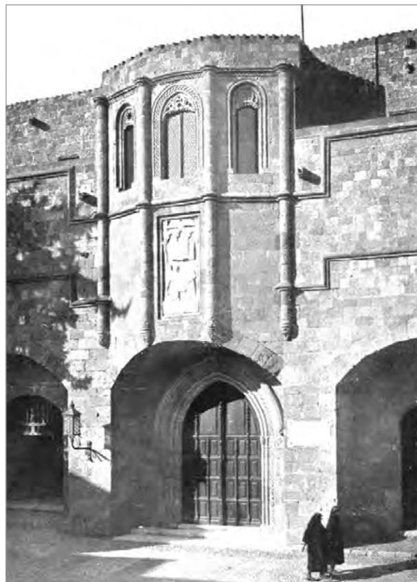
Fig. 1.18. Rodi, Grande Ospedale dei Cavalieri, trasformato in Museo Archeologico, l'ingresso principale dopo i lavori di restauro (da MAIURI 1962).
