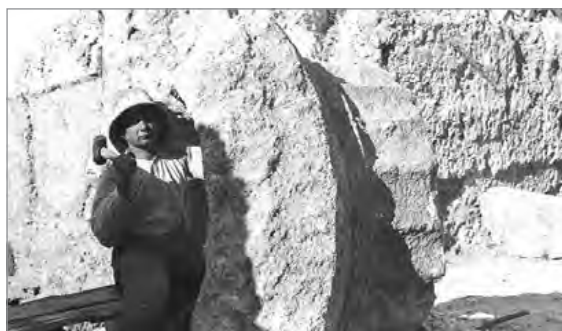
Fig. 1.41. Rodi, acropoli, il tempio di Apollo Pythios, durante il restauro: il capitello originale viene forato per inserirvi la struttura in cemento armato (© Fondo Paolini 712: LIVADIOTTI-ROCCO 1996).
