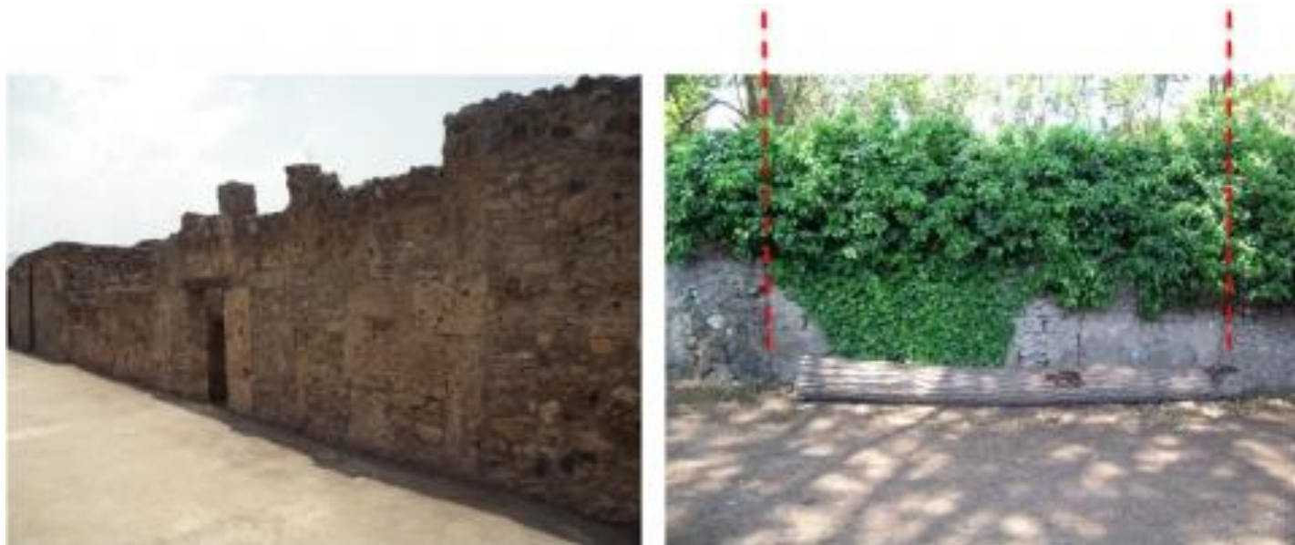
Fig. 9 - L'occupazione delle Regiones I e II in età sannitica: facciata in opera quadrata della domus I, 16, 5 e ingresso tamponato nell' insula II, 3.
