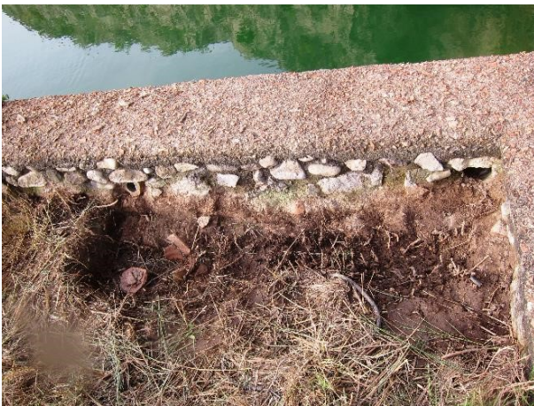
Fig. 13 - Dettaglio della tecnica edilizia sul lato interno dei muri perimetrali dell'isolotto (foto F. Pesando)
