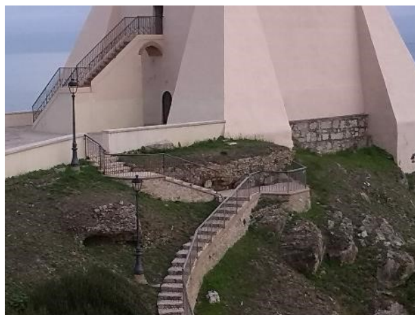
Fig. 34 - Strutture al di sotto della Torre Truglia (foto M. Stefanile)
