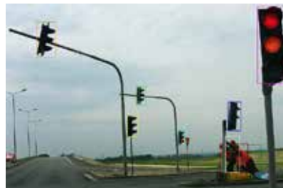
(c) English: The workers are trying to pry up the damaged traffic light , Italian: I lavoratori stanno cercando di tirare su il semaforo danneggiato .
