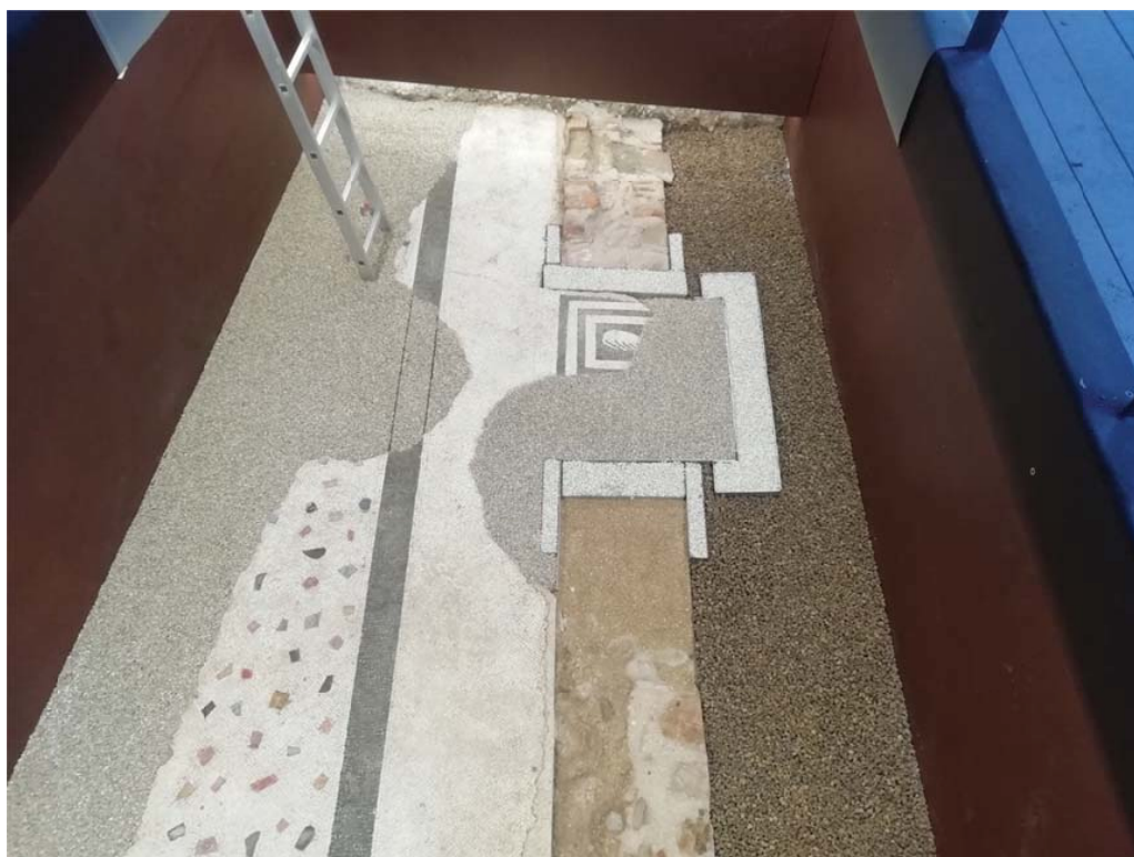
Fig. 46 - Integrazioni delle lacune della pavimentazione musiva, delle murature e degli elementi lapidei associati alla soglia di ingresso del vano
