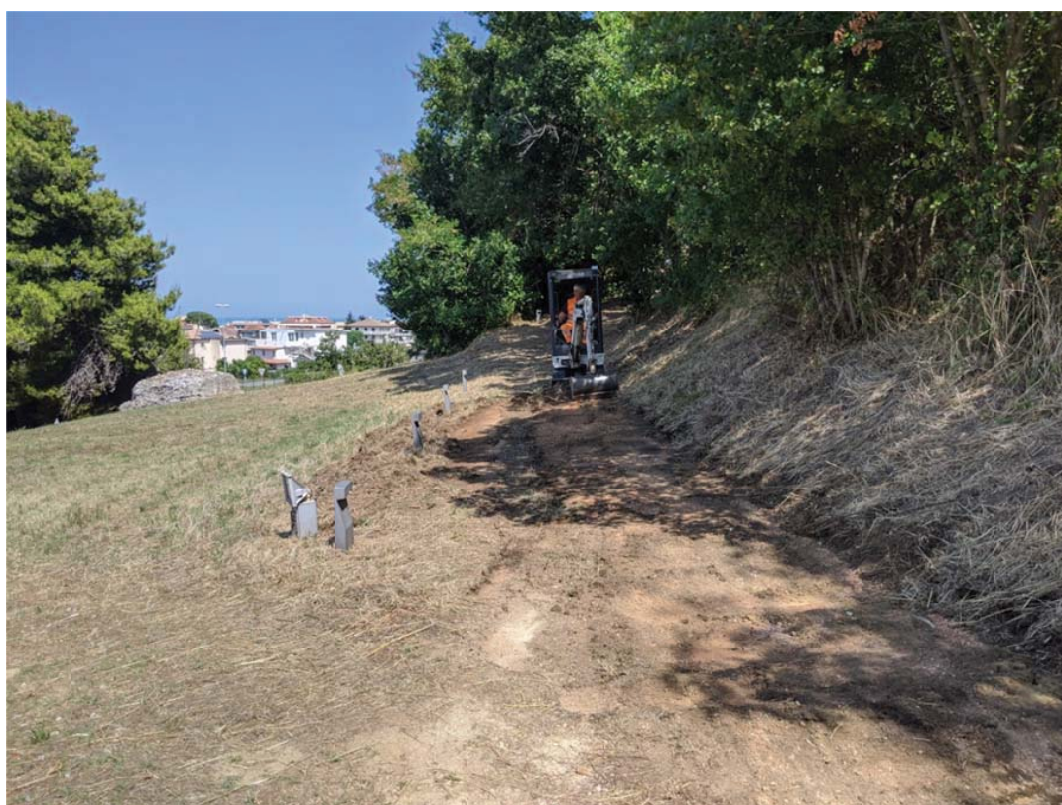
Fig. 20 - Il ripristino degli accessi pedonali
