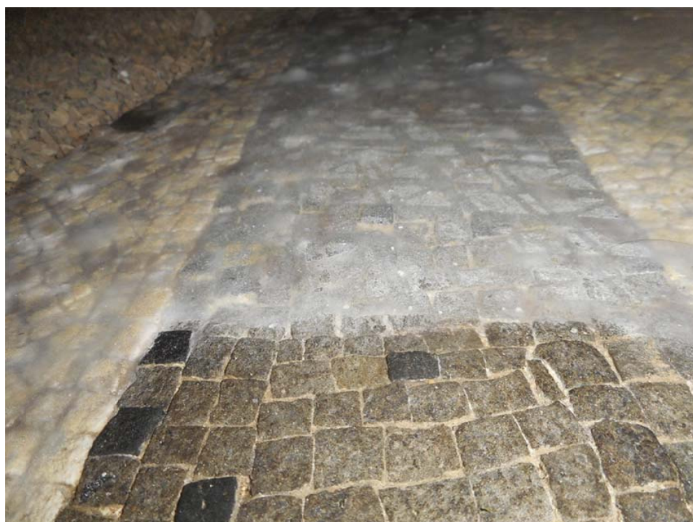
Fig. 44 - Eliminazioni delle muffe
