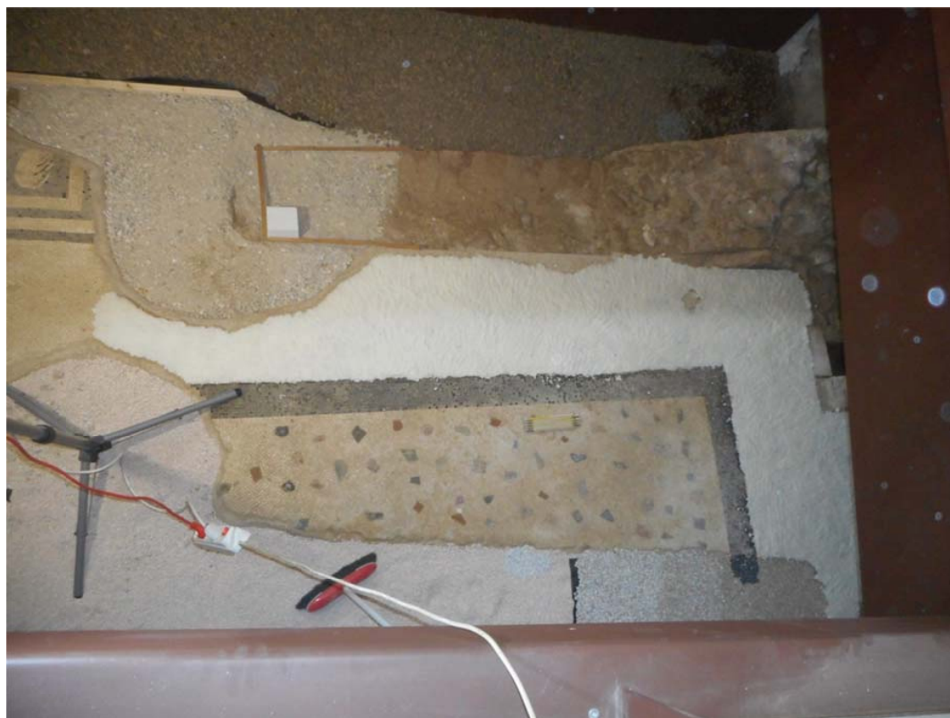
Fig. 42 - Applicazione dell'impacco per la pulitura chimica della superficie
