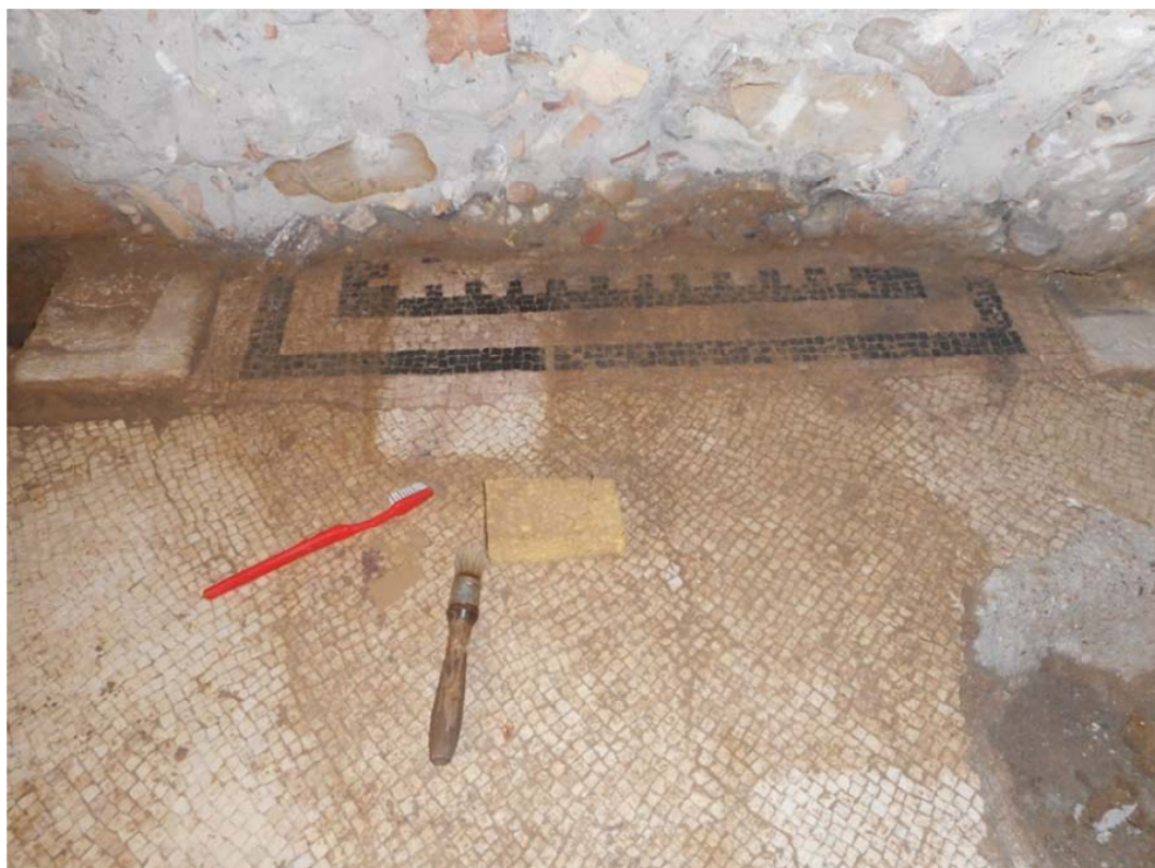
Fig. 40 - Pulitura a amido della superficie musiva
