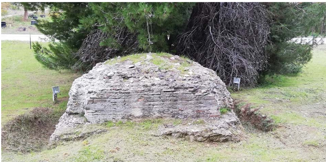
Fig. 5 - Basamento di tomba con nucleo in opera cementizia e laterizi
