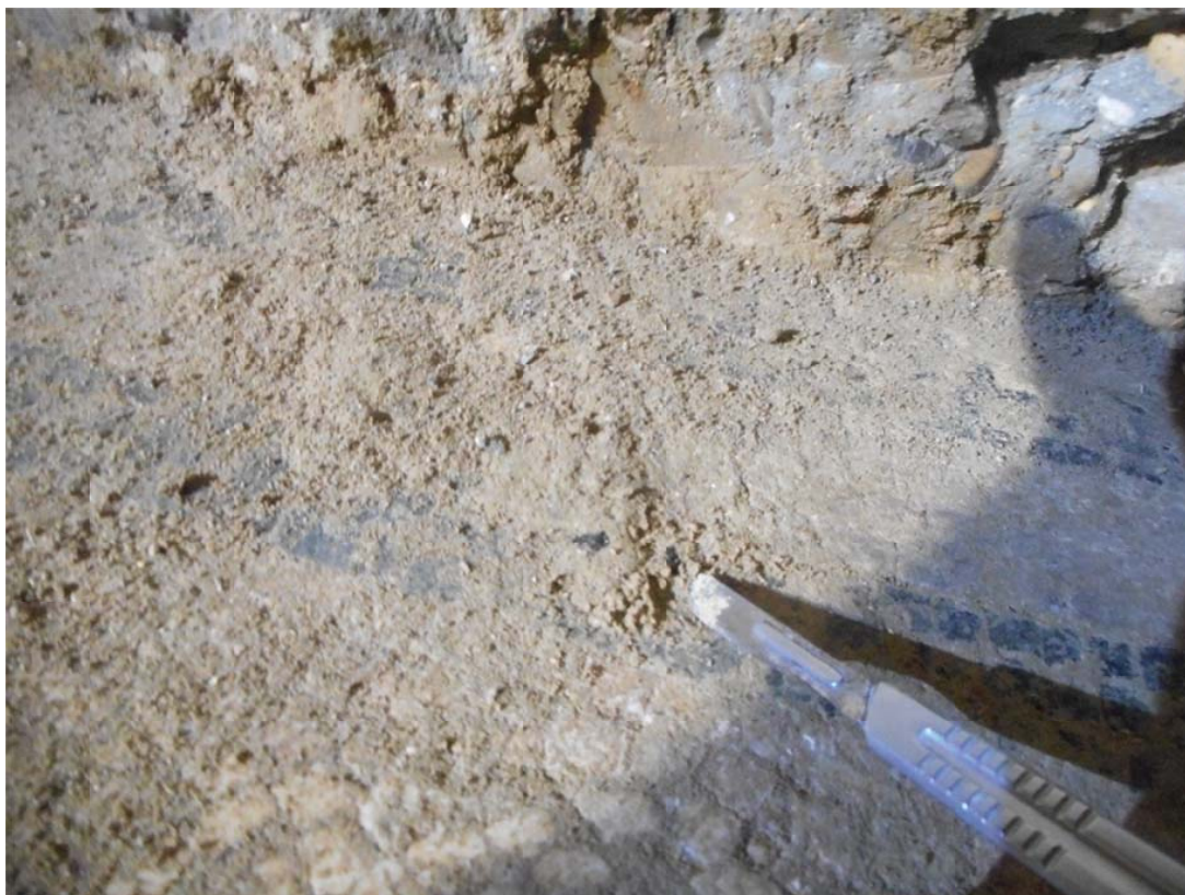
Fig. 38 - Depositi di concrezioni calcaree sulla superficie musiva
