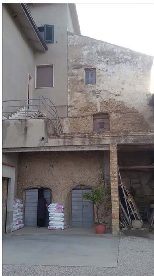
Fig. 2 - "Bagni di Nerone", caput aquae dell'acquedotto di Cupra Marittima risalente al 7 A.C. Le due cisterne in cementizio sono definite dall'iscrizione come opera signina , rara, se non unica, attestazione dell'effettivo valore semantico dell'espressione
