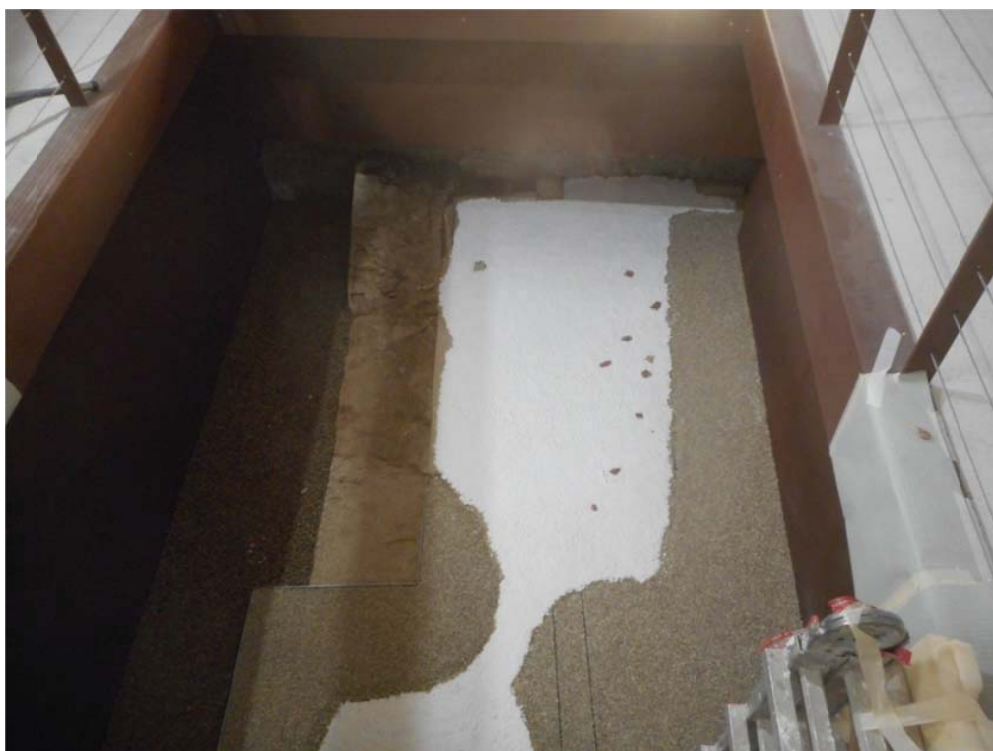
Fig. 43 - Applicazione di impacco estrattivo finale
