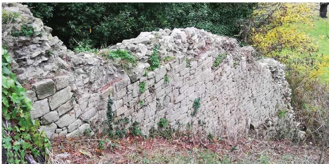
Fig. 6 - Muro in opera vittata
