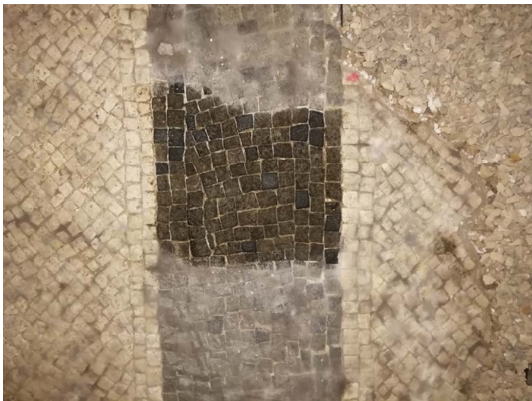
Fig. 39 - Velo di muffe sulle superfici delle strutture
