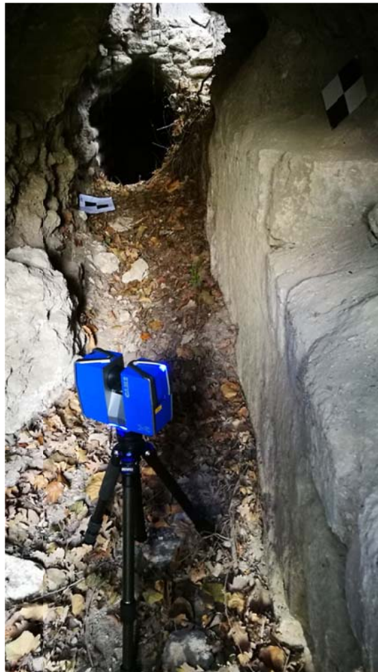
Fig. 4 - Operazioni di rilievo con laser scanner. Collegamento entrata acquedotto mediante target
