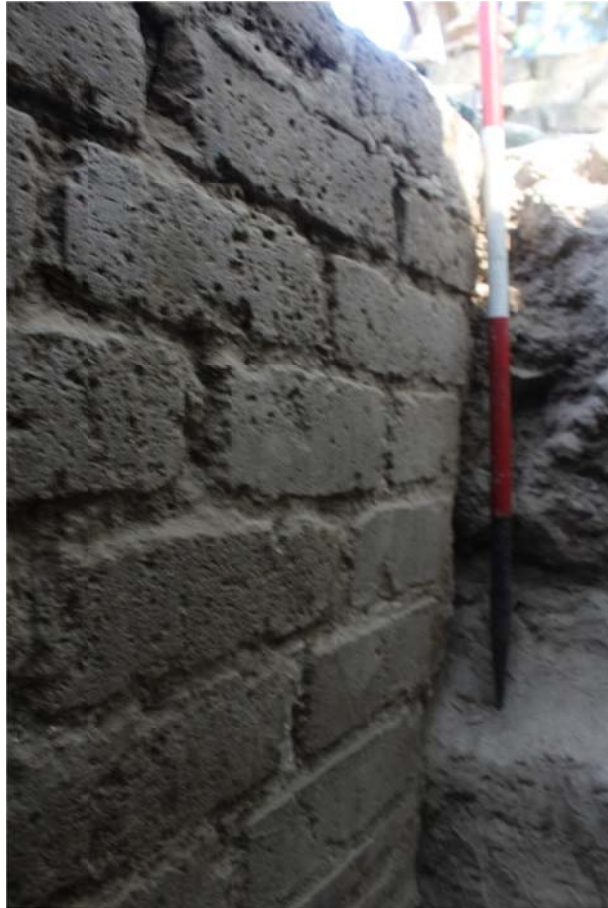
Fig. 5 - Il punto di contatto tra US29 ed il banco di cinerite
