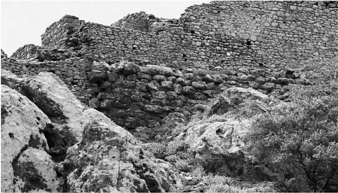
Fig. 26 - Myrina, Kastro . Muro di sostruzione antico nella fortificazione turca (foto autore)
