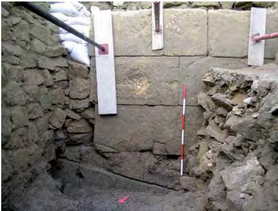
Fig. 65 La fortificazione RMP22085 della fase Ib2 da SW.
