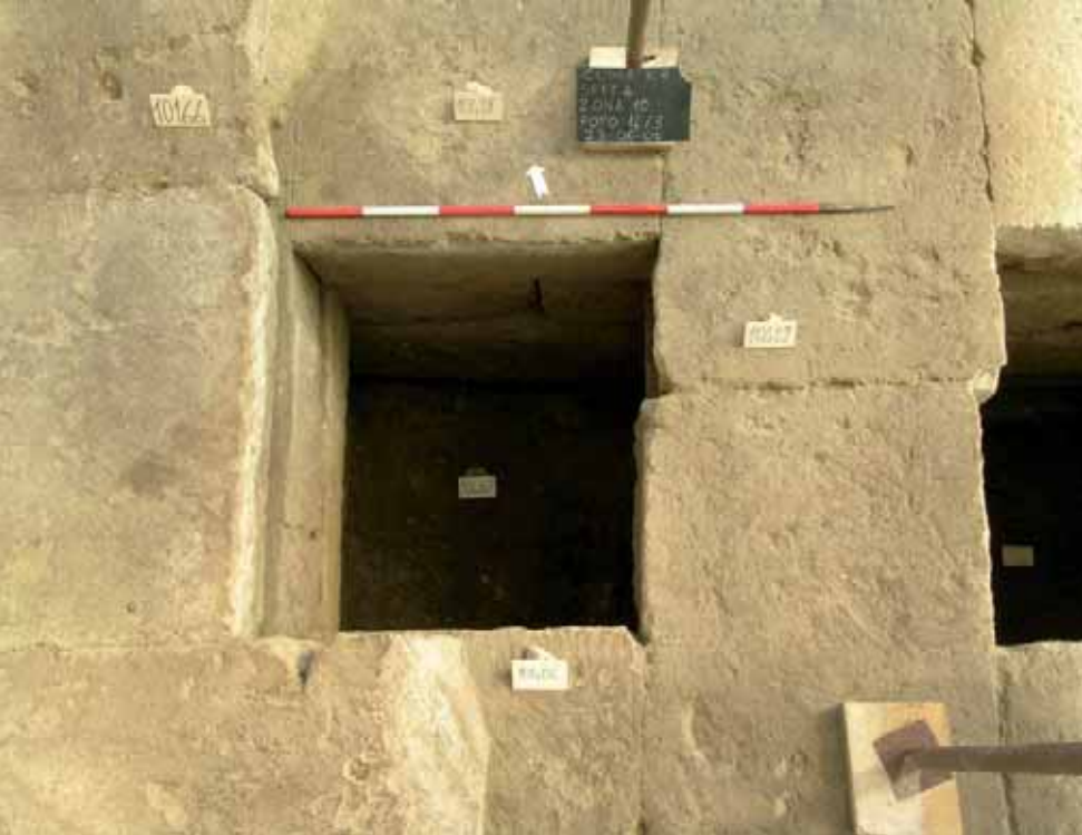
Fig. 29 Asportazione dell' emplekton EM10432 nel comparto SW della testata PRG10427.
