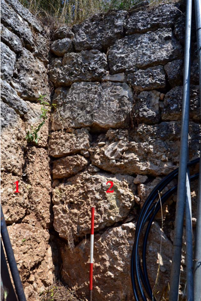
Fig. 21 - Sito SDSA - Unità1, punto di contatto tra la postierla (1) ed il bastione (2)
