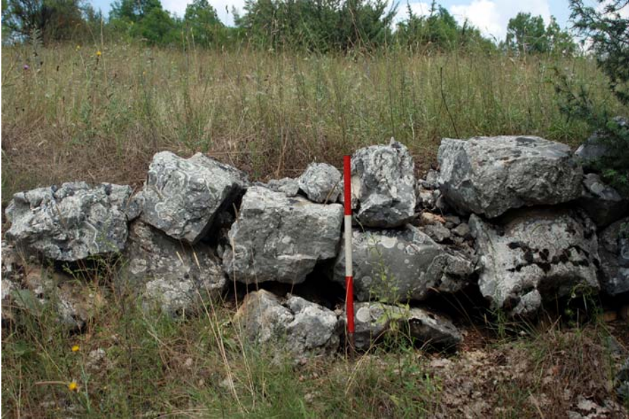
Fig. 3 - Sito OCSA - particolare della tecnica edilizia del muro di terrazzamento
