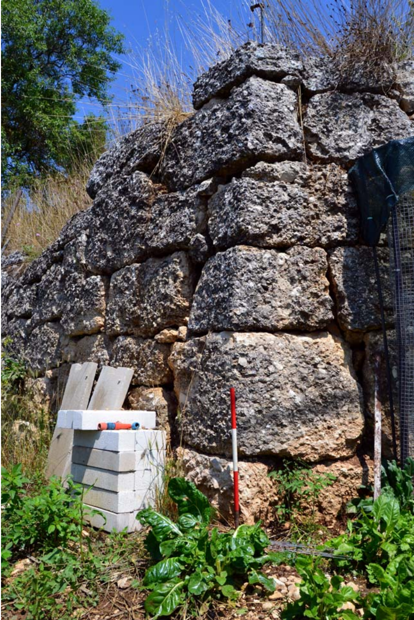
Fig. 18 - Sito SDSA - Unità1, l'angolo del bastione, particolare della tecnica edilizia
