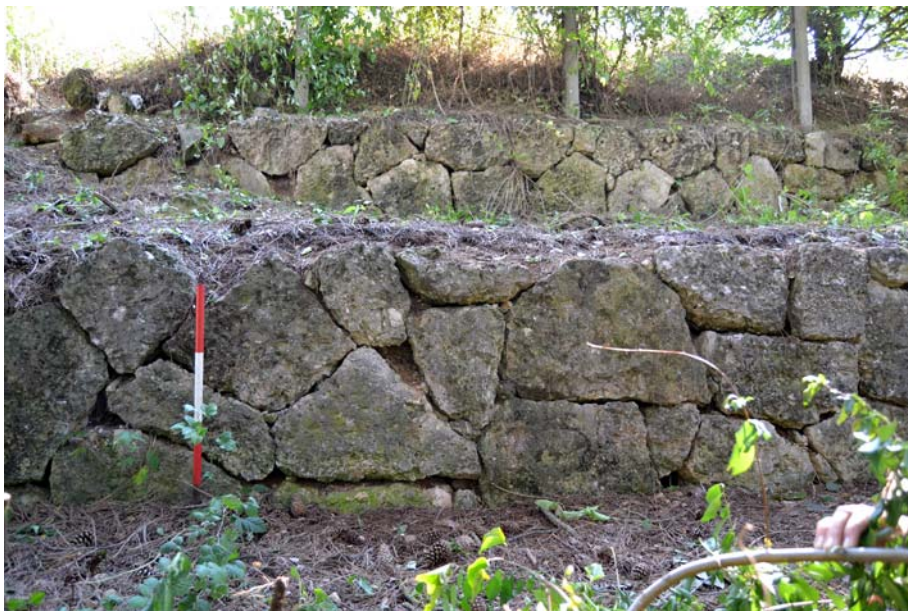
Fig. 26 - Sito SDSA - Unità2, muro inferiore e superiore
