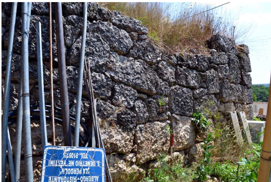
Fig. 17 - Sito SDSA - Unità1, il bastione
