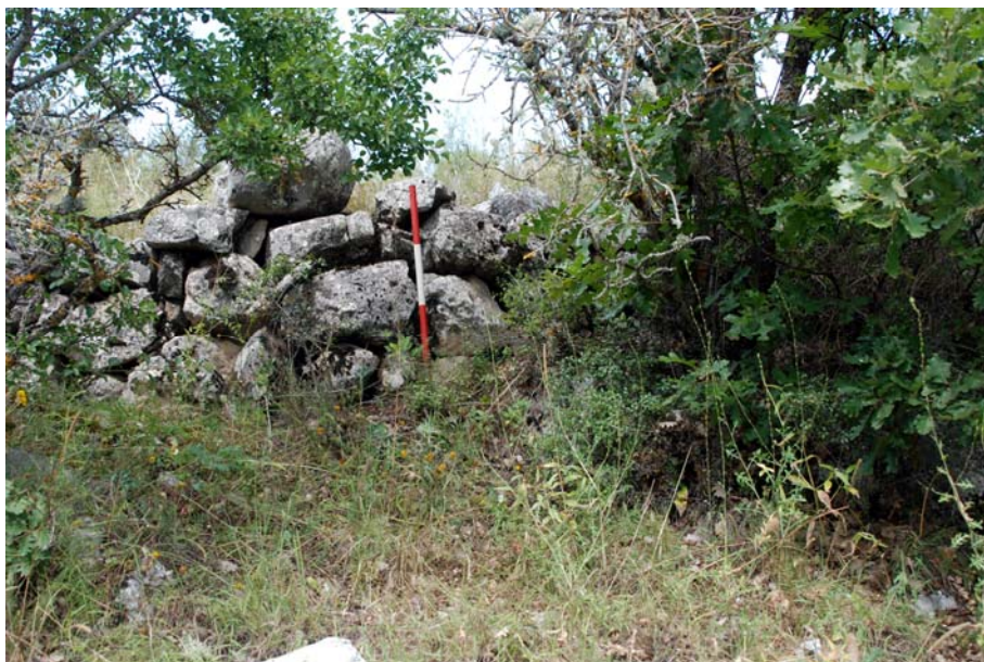
Fig. 2 - Sito OCSA - muro di terrazzamento in opera poligonale
