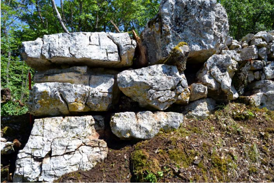
Fig. 14 - Sito SETB - il muro di terrazzamento
