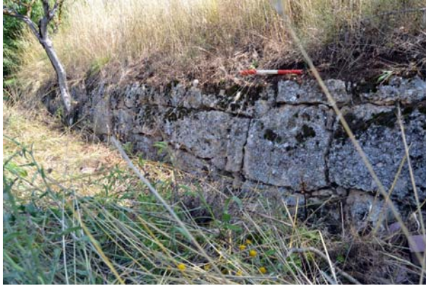
Fig. 24 - Sito SDSA - Unità1, muro superiore
